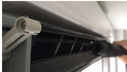
3. Wanneer het rooster open is, kunt de binnenkant met de stofzuiger schoon zuigen. Klik daarna het afde krooster weer voorzichtig terug op zijn plek.
